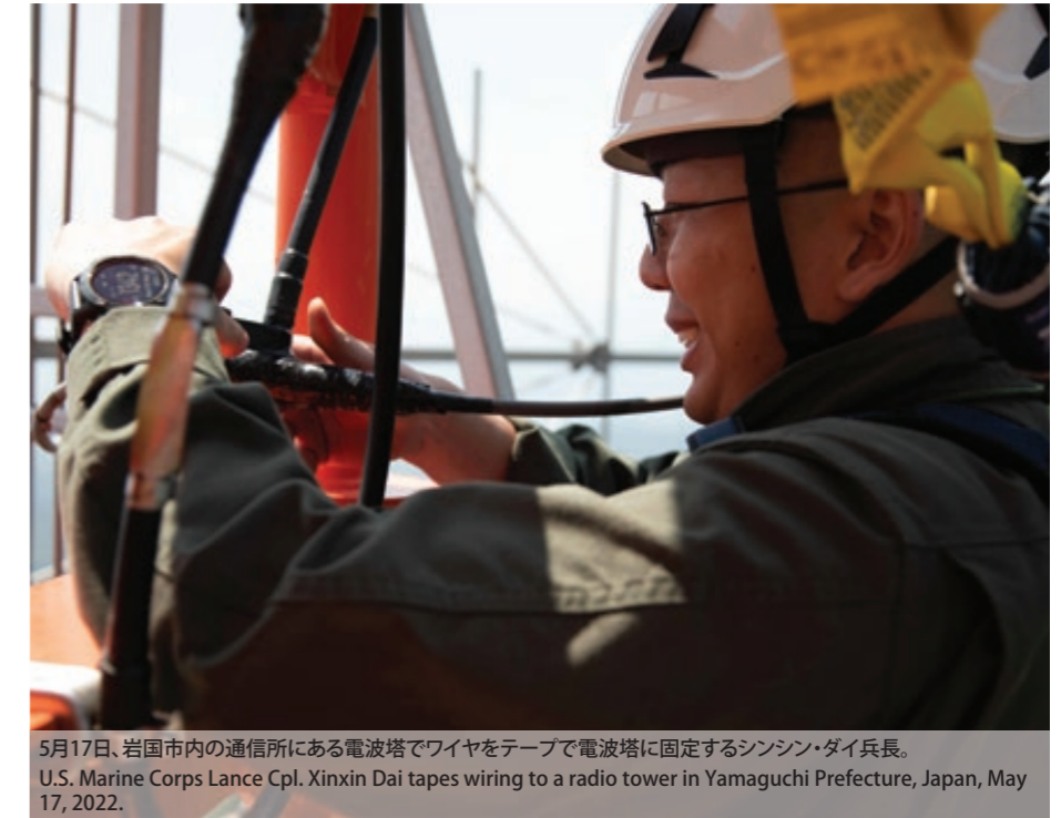
5月17日、岩国市内の通信所にある電波塔でアンテナを修理するシンシン・ダイ兵長。 U.S. Marine Corps Lance Cpl. Xinxin Dai prepares to fix an antenna at a radio tower in Yamaguchi Prefecture, Japan, May 17, 2022.
